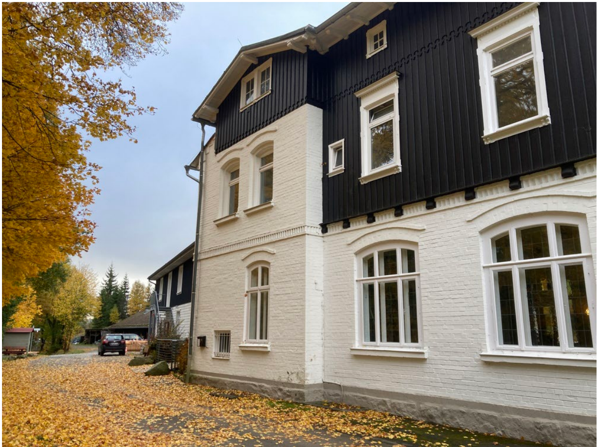
Das Jugendgästehaus im Brunnental. Das Gebäude ist der ehemalige Bahnhof Brunnenbachsmühle. Ab 1899 fuhr hier die Südharzisenbahn. 1945 wurde durch die deutsche Teilung der Zugverkehr eingestellt.
