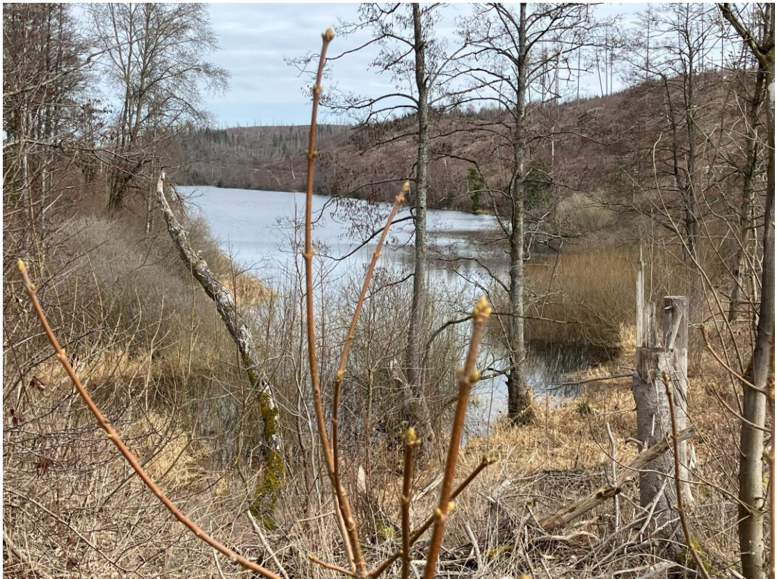
Da liegt sie, die kleinste Talsperre im Harz.
