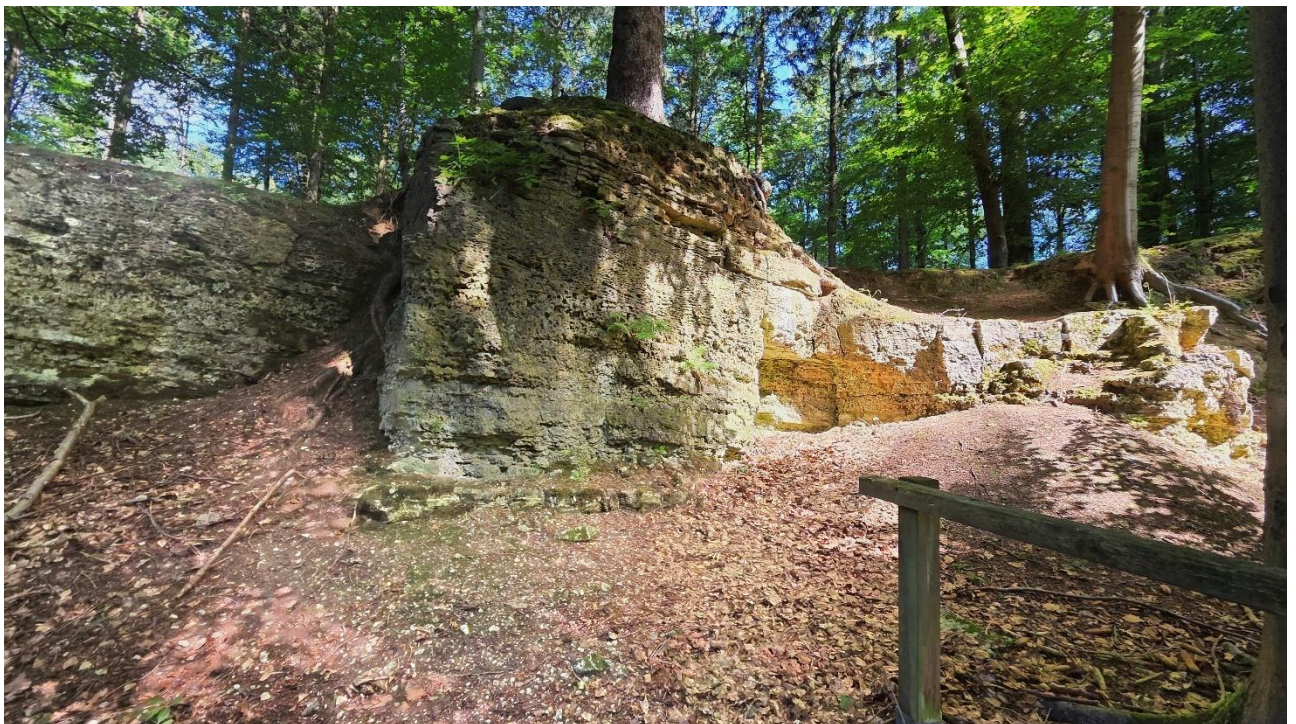
Der Steinbruch ist deutlich zu erkennen. Arbeiten finden nicht mehr statt.
