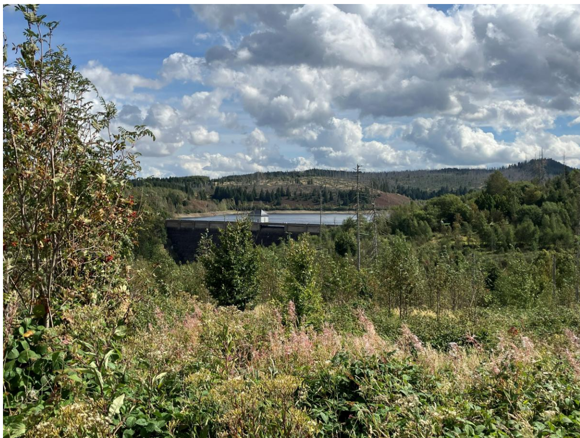
Ein Blick zurück zur Staumauer der Eckertalsperre.
